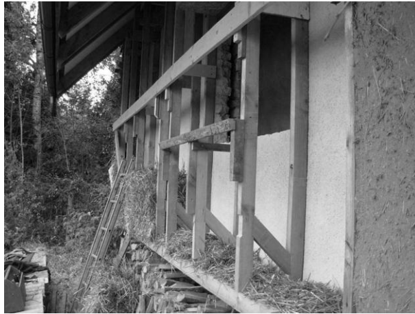
3 pav. Šiaudais šiltinamos sienos karkasas
