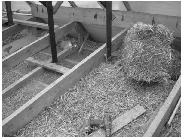
2 pav. Stogo šiltinimas šiaudų ryšuliais
