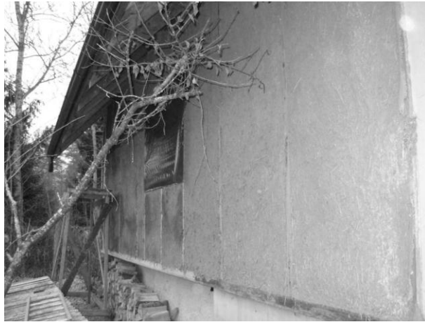
5 pav. Pirmuoju molinio tinko sluoksniu nutinkuota siena
